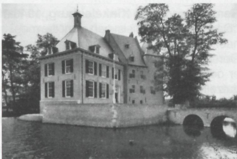
De Kinkelenburg na de restauratie.
