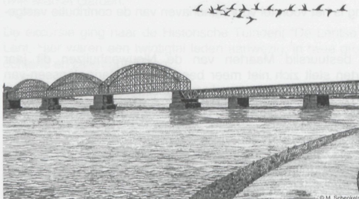
Oorspronkelijke Spoorbrug over de Waalbrug.
