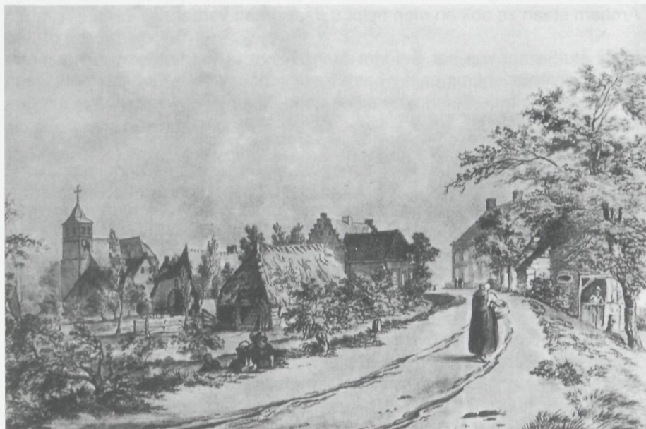
Het huis met de trapgevel is het huis van de Schout. Pasteltekening van C. Kruijf.
