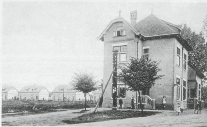
Administratie Gebouw B. S. M. - Bemmeler
