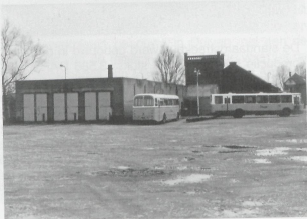
Afb. 58. Het terrein aan de Karstraat in 1975. Details van de vroegere gebouwen van de BSM zijn nog zichtbaar.
