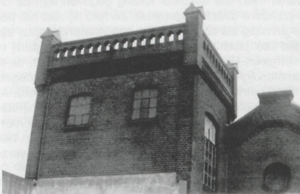
Afb. 60. Een opvallend detail van de in 1908 gebouwde BSM remise aan de Karstraat: de toren, hier in 1975 vanuit het noordwesten gefotografeerd. Het gepleisterde muurdeel bevond zich ooit aan de binnenkant (zie afb. 59).
