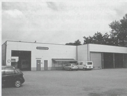
Afb. 76. Het busstation in Bemmelen in 2006.
