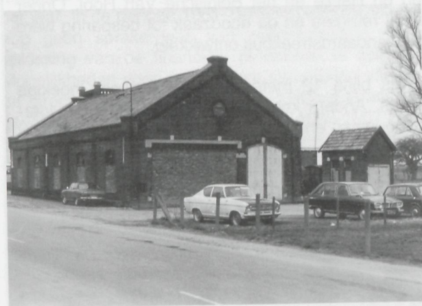
Afb. 57. Aan het eind van de zestiger jaren lagen de gebouwen van de GTW aan de Karstraat er niet bepaald florissant bij. Deuren en ramen zijn dicht gemetseld.
