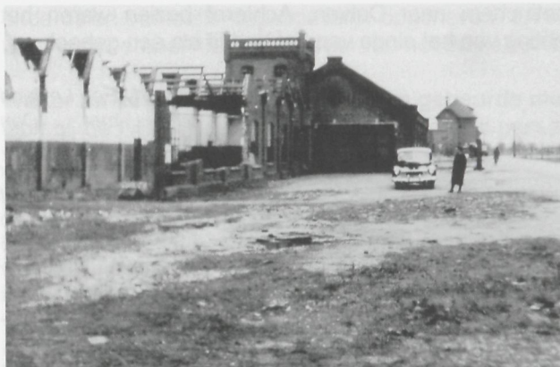
Afb. 59. Een deel van de oorspronkelijke gebouwen van de BSM in Bommel wordt hier afgebroken. Goed zichtbaar is dat het dak van de loodsen hier nog uit meerdere schuine delen bestond. Ook zien we in het midden een deel van de karakteristieke toren. Zie ter vergelijking afb. 10. Vermoedelijk werd deze foto begin jaren vijftig gemaakt.
