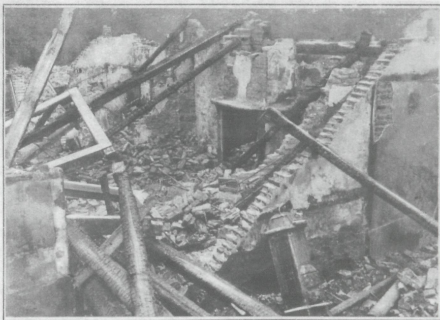
De kapitale boerderij van den heer Philips te Haalderen is door onbekende oorzaak geheel verbrand. Overzicht van het totaal verwoeste achtergedeelte der boerderij.
