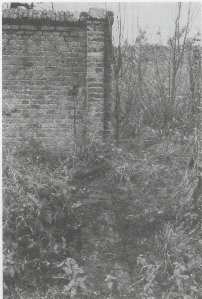
Het andere eind van de muur met op de voorgrond de fundering van het verdwenen muurdeel.
