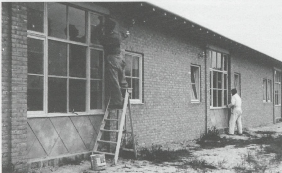
Noodwoningen in aanbouw.
