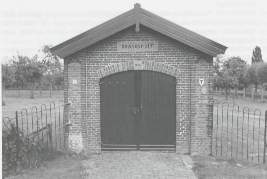
Aan het begin van de vorige eeuw werd hier de Ressense brandspuit gestald.
