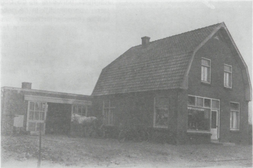
Het nieuw gebouwde woonhuis met winkel en smederij aan de van der Mondeweg
