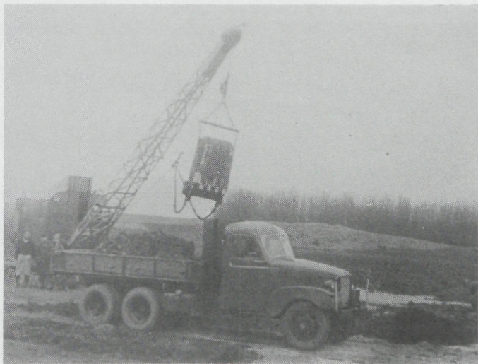
Aan het werk in Zeeland na de watersnoodramp van 1953
