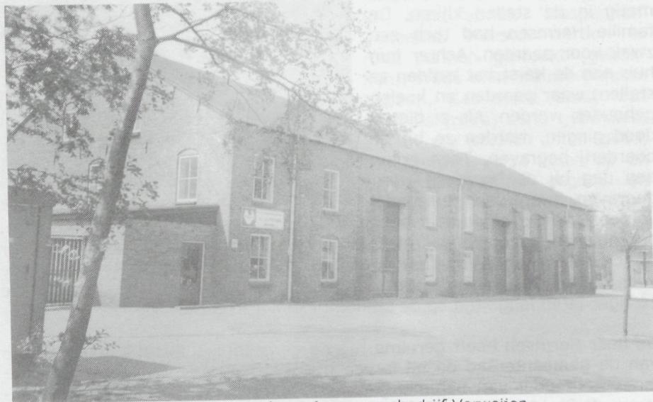
Het huidige pand van Aannemersbedrijf Verweijen
