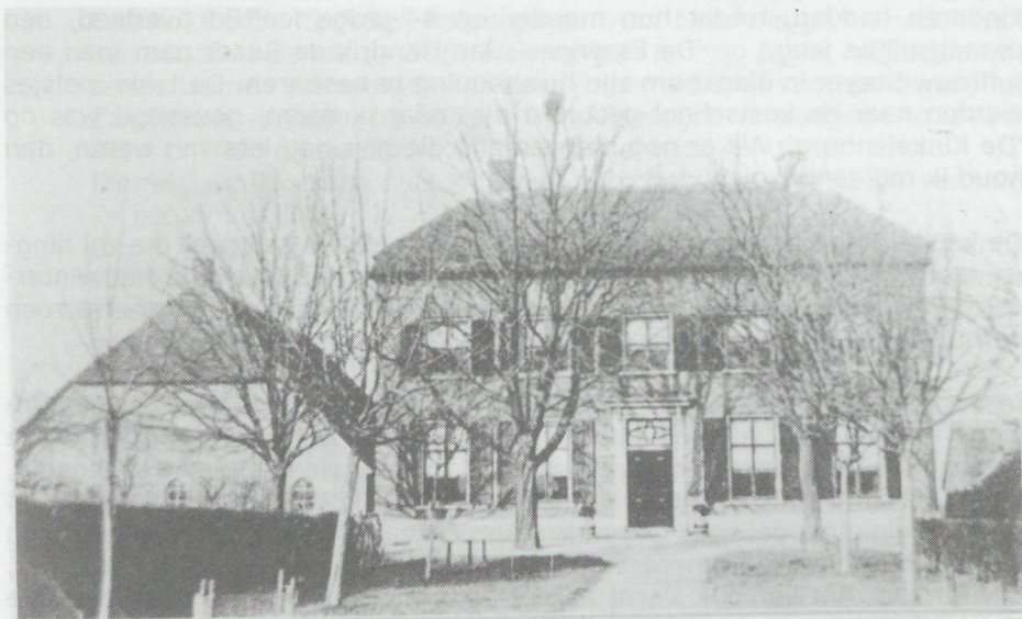
De in 1842 gebouwde en in 1944 verwoeste boerderij 'De Essenas'. In de loop van de tijd is aan dit huis een serre aangebouwd. Op de foto is deze nog niet te zien.
