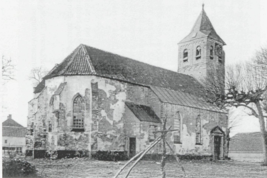
De kerk direct na de oorlog. De ingang is nog aan de noordzijde. De wijzerplaat zit half voor een galmgat. Het onderste deel van het dak is al provisorisch gedicht.
