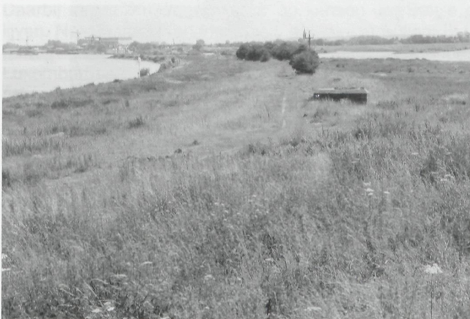
Een kazemat als voorpost op de dam die de scheiding vormt tussen het Pannerdensch Kanaal (links) en de Waal. Controle over de verdeling van het water was van vitaal belang om te voorkomen dat de vijand het kanaalwater dat bestemd was voor de waterlinie zou afleiden naar de Waal.
