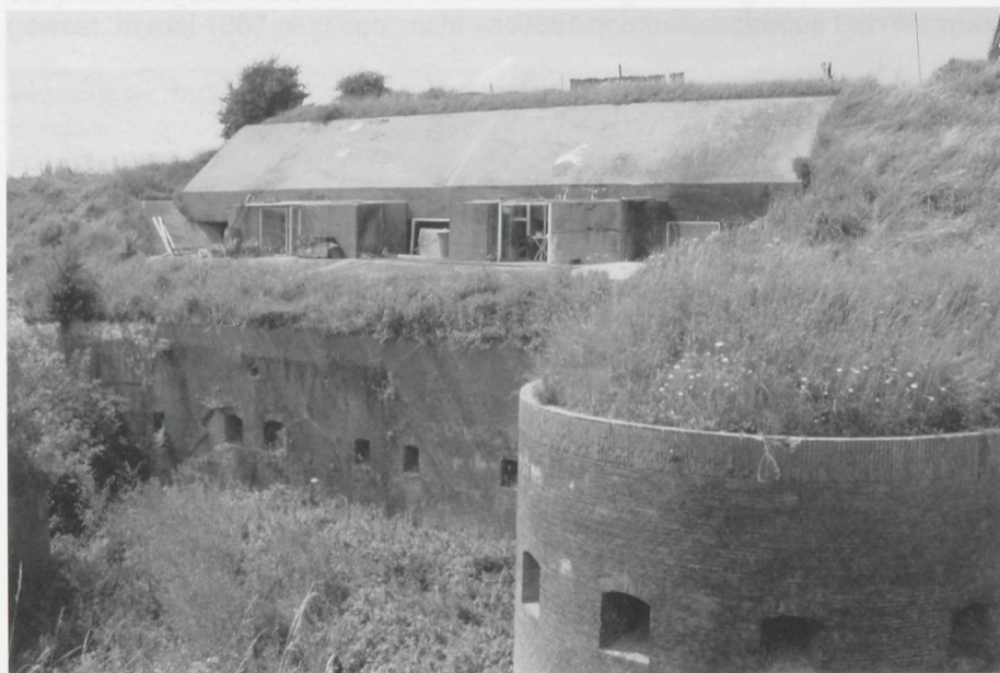
De voormalige hoofdbatterij van Fort Pannerden, waarvan de zware kanonnen het Bijlandsch Kanaal konden bestrijken. Vooraan een caponnière: een halfronde uitbouw vanwaar flankerend vuur kon worden uitgebracht op de droge gracht.
