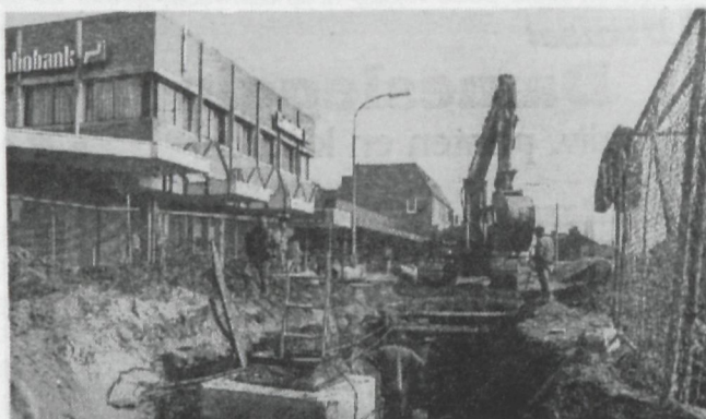
● Voordat de promenade gerealiseerd kon worden is eerst de riolering vernieuwd. Een opname van april 1992.
