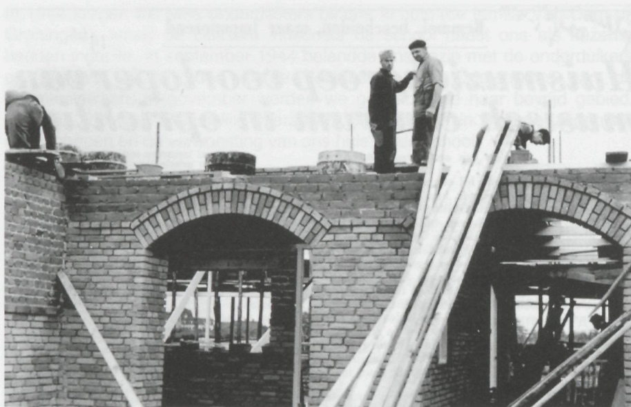
De bouw van de PIUS X school vordert gestaag.
