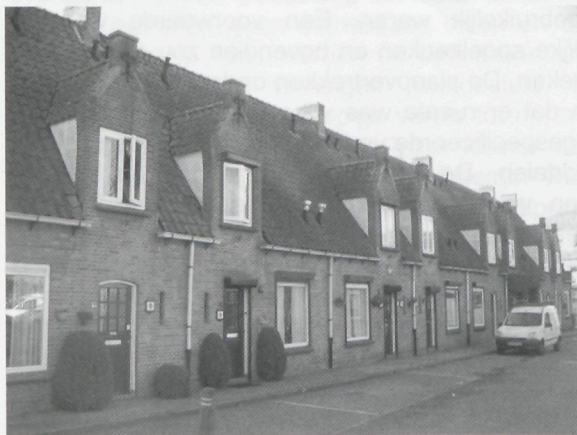
Door prof. ir. J.F. Berghoef ontworpen arbeiderswoningen aan de Van Deventerstraat in het tijdens de Tweede Wereldoorlog herbouwde Rhenen.
